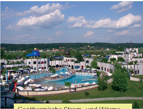
Geothermische Strom- und Wärme- produktion für das Thermalbad Bad Blumau, Österreich (Foto F.-D. Vuataz)
